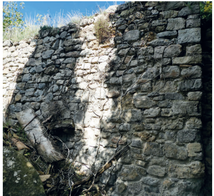
Vista parcial del muro sur de la casa del Señor. Presenta al menos dos fases constructivas.
