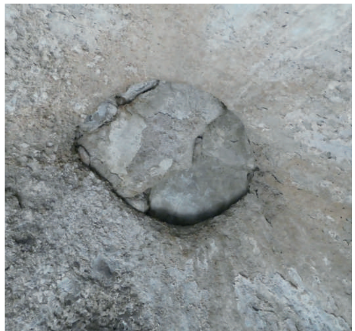
Techo de la cárcel, con apertura cegada en la actualidad.
