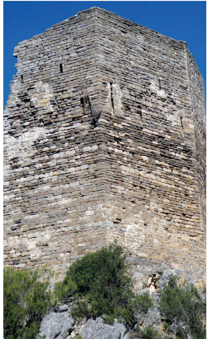
Torre del castillo de Escanilla, ya en estado ruinoso en 1566.
