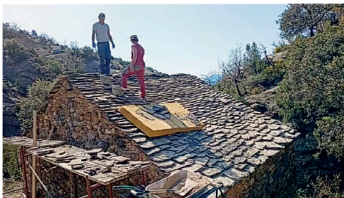
Tejado del molino de La Cabezónada una vez restaurado.
