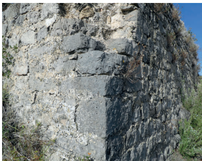
Esquina sureste del castillo. Piedras bien trabajadas, de gran calidad, resistentes a la erosión, asentadas con buen mortero de cal.
