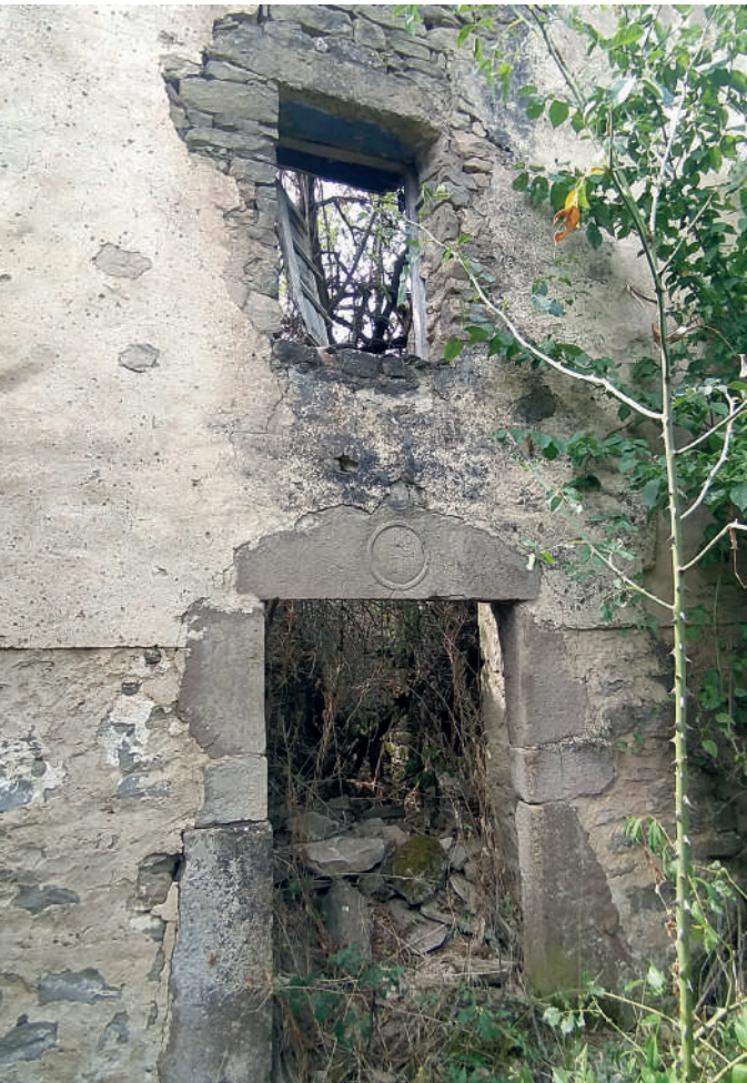
Fachada de casa Escartina (2022).
