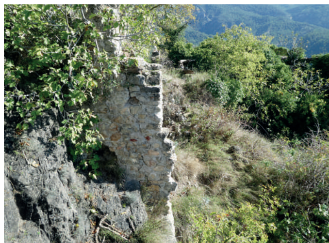
La casa del Señor estaba parcialmente cimentada en la roca del espolón rocoso. Sus muros más antiguos son los de mejor calidad.
