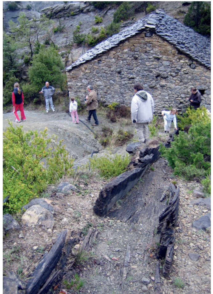
Canal de quejigo negro que lleva el agua del río La Nata al molino harinero de La Cabezonada.
