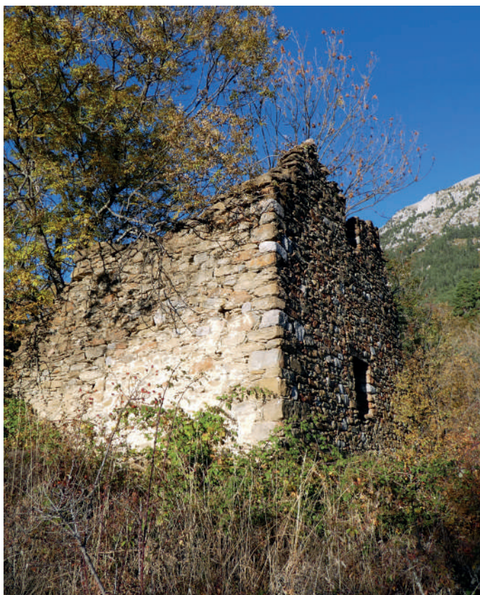
Edificio en ruinas, en la Carlanía de Gistali.
