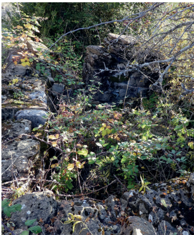
Algunas construcciones han quedado reducidas a la mínima expresión, señal de llevar mucho tiempo abandonadas.
