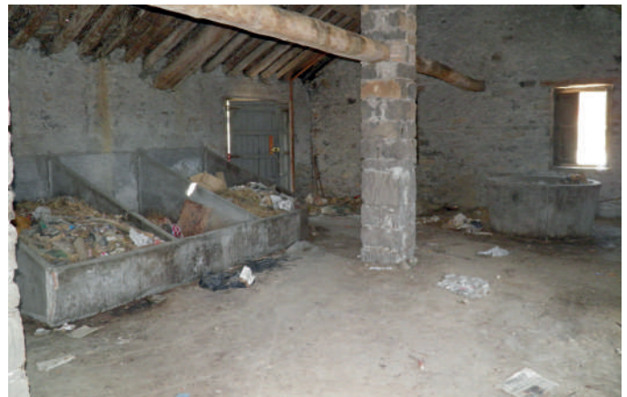
Vista de la planta superior antes de la rehabilitación. Los alguarines a la izquierda y a la derecha la tolva por la cual se echaban las olivas a los ruellos .
