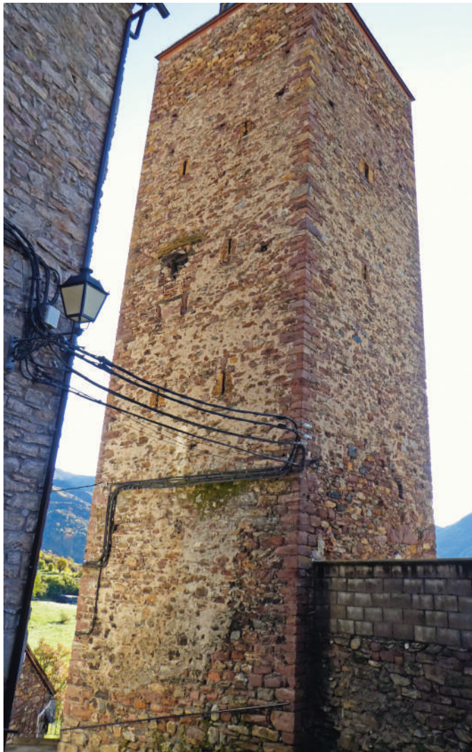
Figura 6. Torre de Rins, fachadas norte y oeste.
