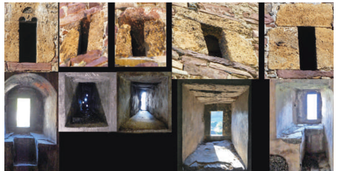
Figura 12. Torre de Rins, vanos en la cuarta planta.
