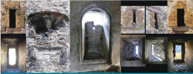
Figura 11. Torre de Rins, vanos en la tercera planta.
