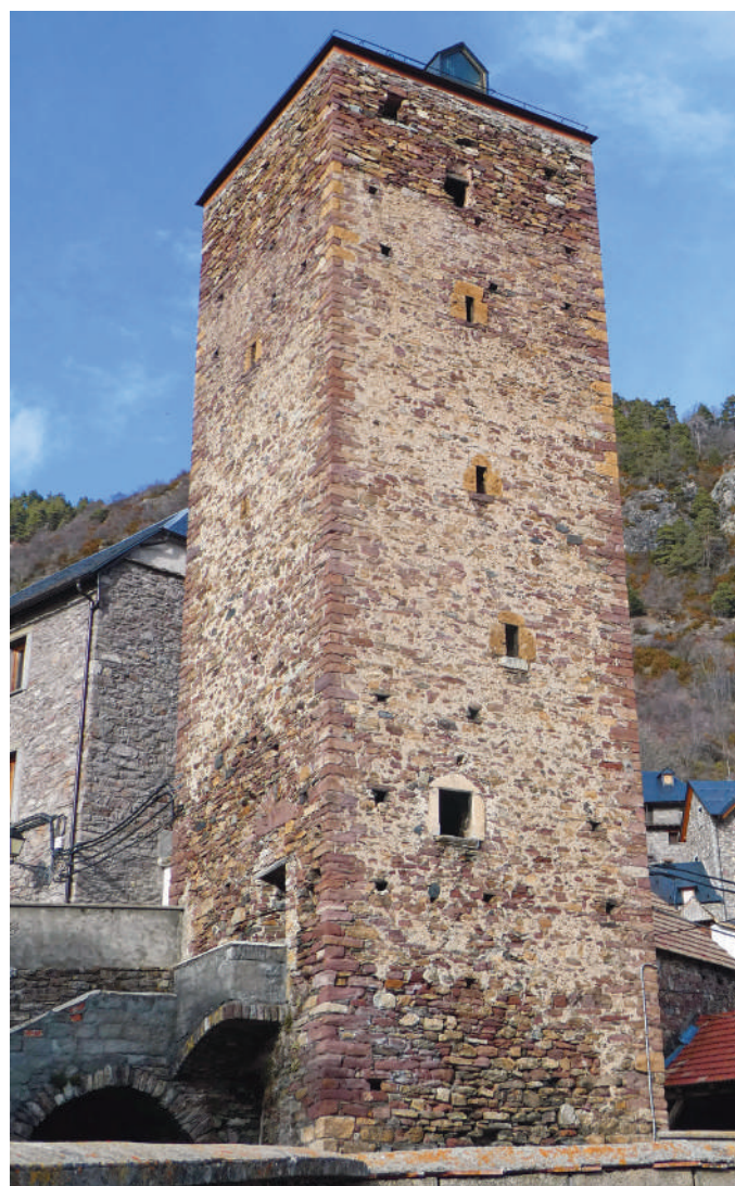
Figura 5. Torre de Rins, fachadas sur y oeste.
