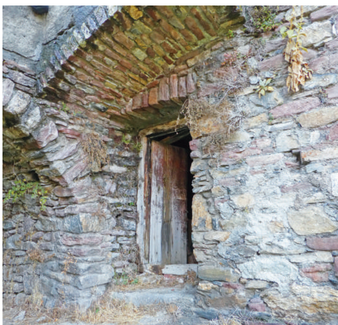
Figura 7. Acceso a la planta baja de la torre.
