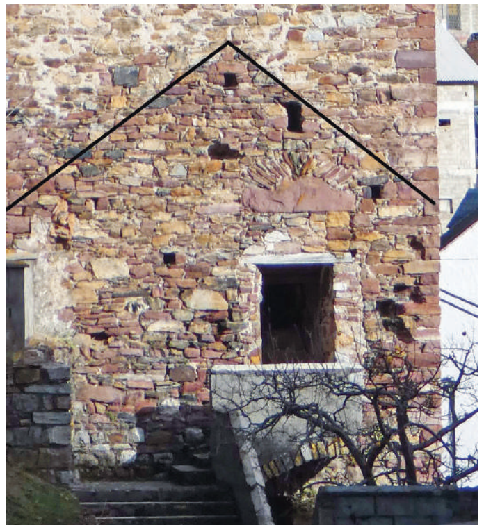
Figura 8. Acceso a la primera planta de la torre. La línea negra indica la ubicación del tejado a dos aguas de la desaparecida Casa Latorre.
