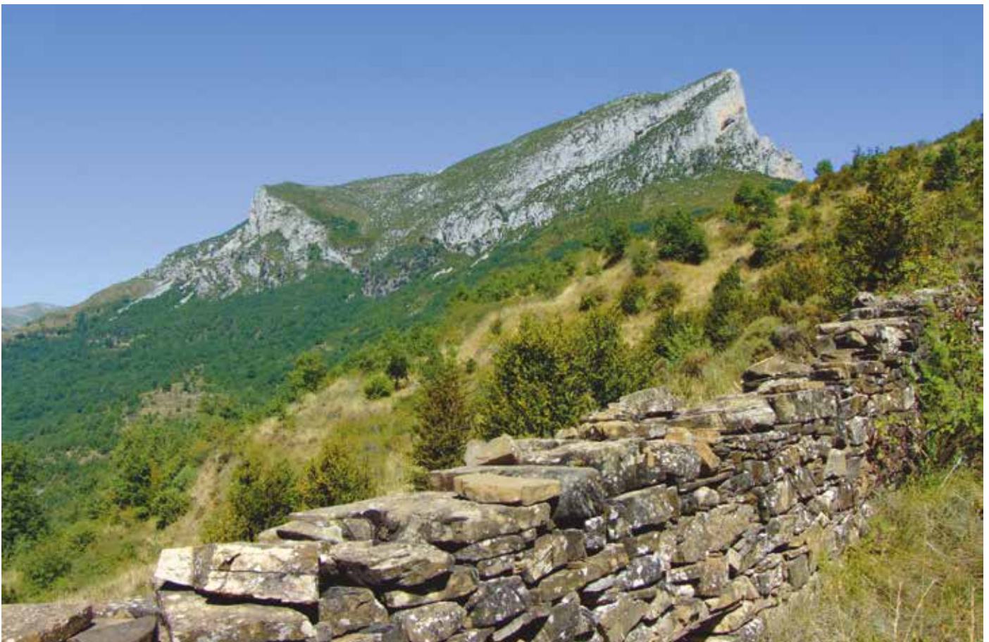
Castillo Mayor de Puértolas, vista general.
