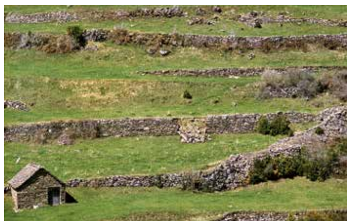
En el valle del río Sorrosal, de Linás de Broto, se adecuaron laderas para el cultivo al elevado precio de levantar muros de sostén y casetas que el tiempo y el olvido quiebran y revientan.
