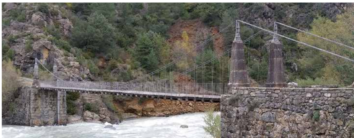
Vista general del puente colgante de Jánovas desde la margen derecha.
