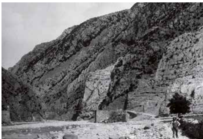
La pasarela de Jánovas en una fotografía de L. Briet, 1911.
