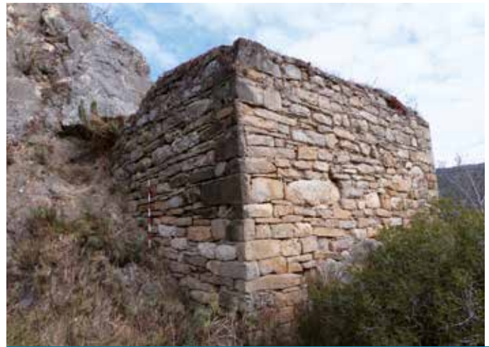
Fig. 5: Parte sur del muro de la terraza.
