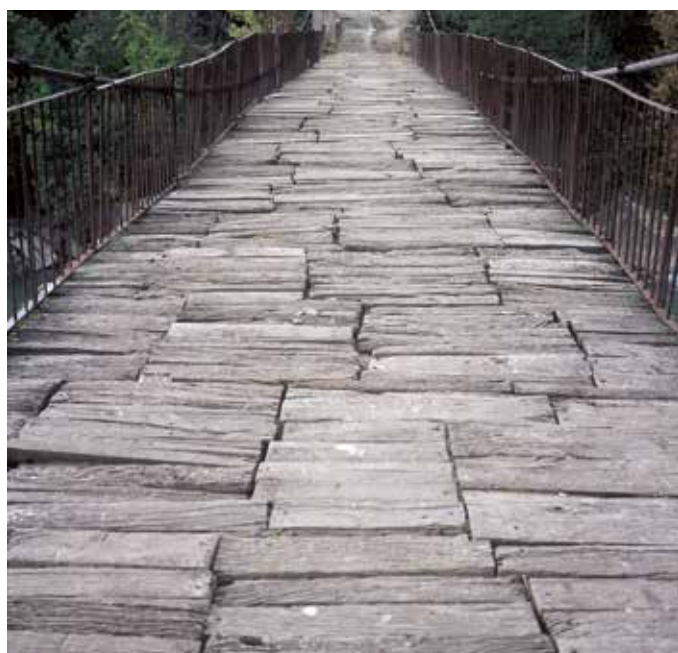
El tablero de la pasarela de Puente de Montañana.
