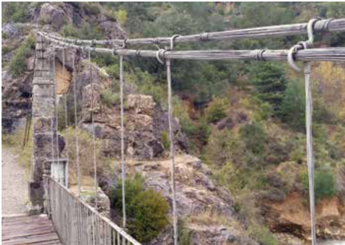
Entramado de cables y péndolas.
