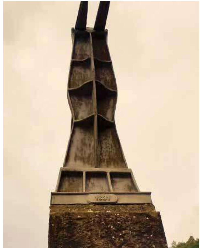
Detalle del puente colgante de Jánovas. Las piezas de fundición que coronan las torres están fechadas en 1881.
