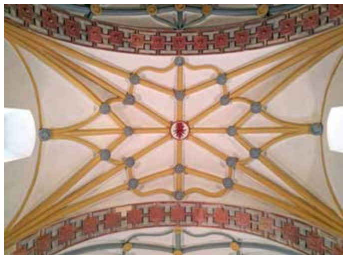
Bóveda estrellada de la iglesia de San Martín de Palo.
