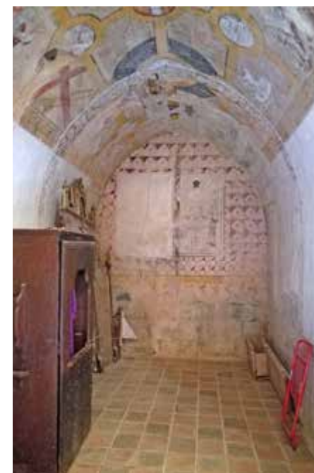
Capilla de bóveda apuntada, perteneciente al templo antiguo.
