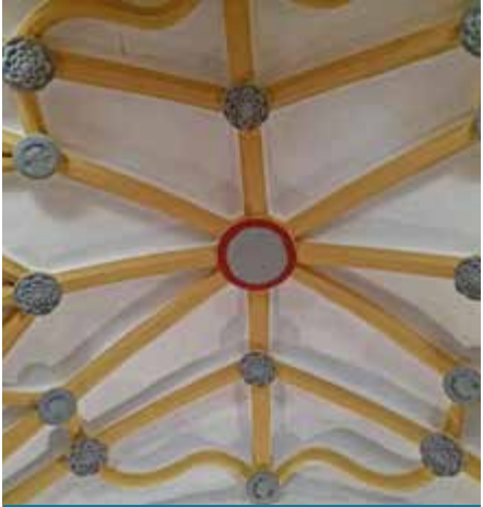
Bóveda estrellada en la nave central de la iglesia de San Martín de Palo
