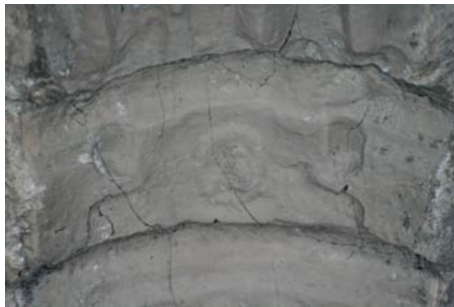
Detalle bóveda capilla en nave lateral norte. Detalle de una mensula en la nave lateral norte.
