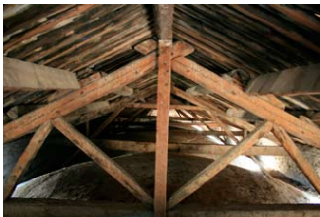
Armadura de madera de la cubierta de la nave central.
