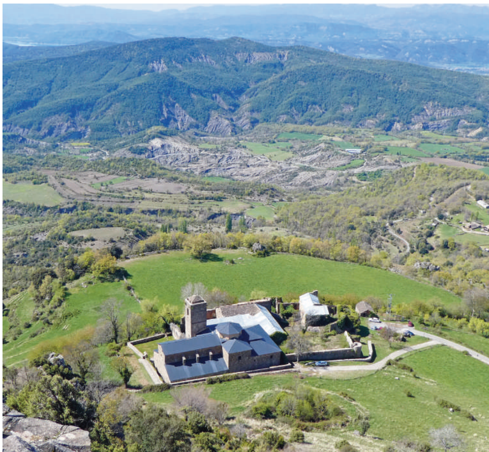
Vista general del monasterio de San Victorián, con gran amplitud visual hacia el sur.
