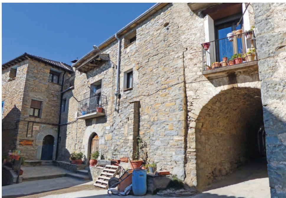
Figura 1. Casa Baile de Troncedo, fachada principal.
