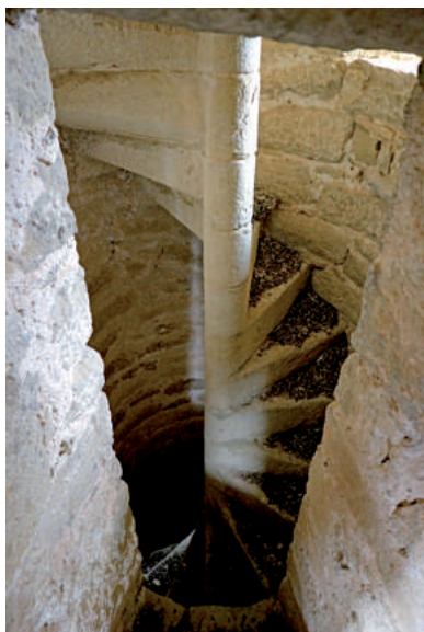
Escalera de caracol del campanario de Abizanda.
