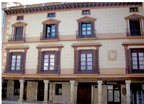
Figura 12. Casa de los Bardaxí en Graus.
