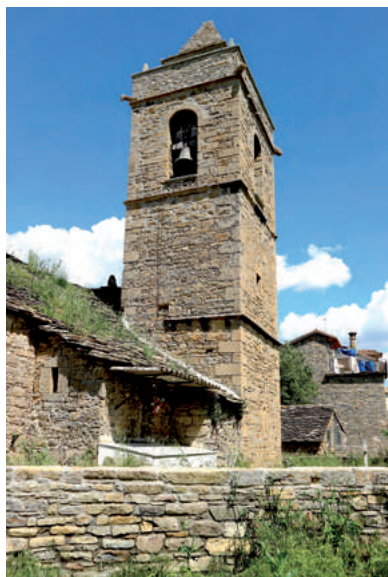
Campanario de sillarejo y sillares. Iglesia parroquial de San Juan Bautista de Camporrotuno.
