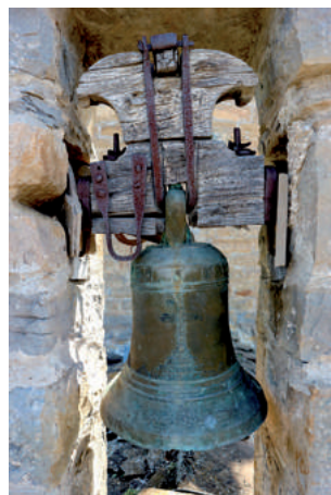
Campana de señales, iglesia parroquial de Coscojuela de Sobrarbe, utilizada a medio bando u oscilación.
