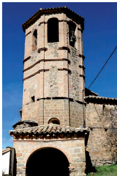
Campanario de sillares, sillarejo y ladrillo. Iglesia parroquial de Santa Cecilia de Bárcabo.
