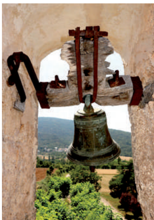
Campana preparada para el toque manual a distancia. Santuario de Ntra. Sra. de Bruis.
