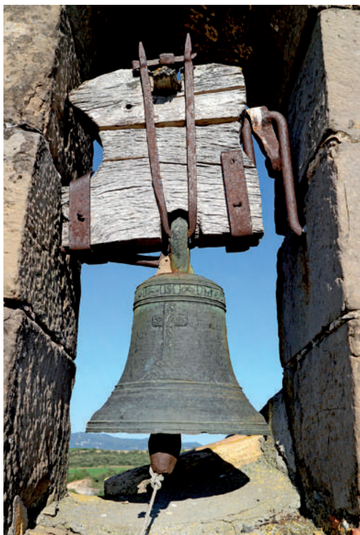
Campana de la iglesia de Javierre de Olsón. Aunque actualmente se repica, tiene un cigüeñal para bandear manualmente a distancia.
