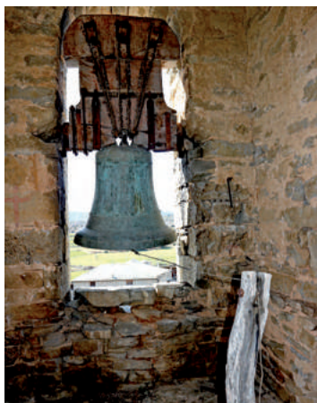
El cable para repicar la campana pasa por medio de la madera para que descienda más fácilmente por el interior de la torre. Iglesia parroquial de Arcusa.
