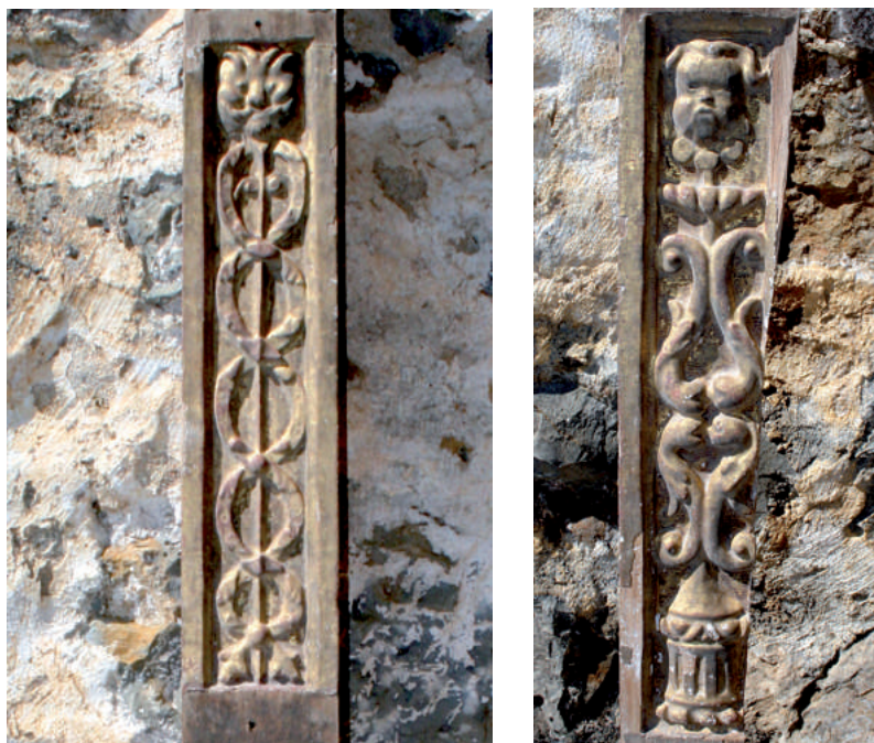
Figura 19. Detalles de la pilastra conservada en la iglesia de San Bartolomé de Silves (el autor).
