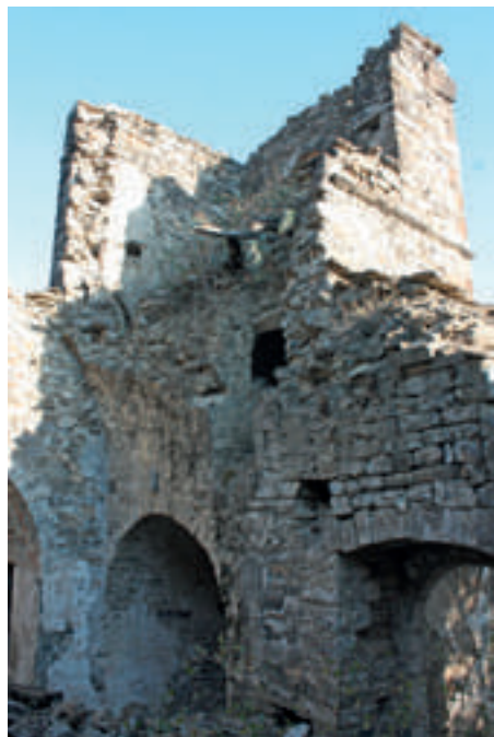
Ruinas del campanario de Belsierre (Puértolas), que permiten ver la técnica constructiva
