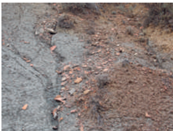
Ejemplo de la gran cantidad de material que puede observarse en el talud
