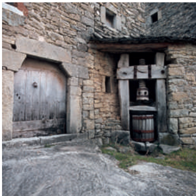
Mondot, la prensa ha desaparecido y el rincón ha perdido su calidad y riqueza. La difícil situación de la arquitectura popular en un pueblo de nuevo habitado por una familia
