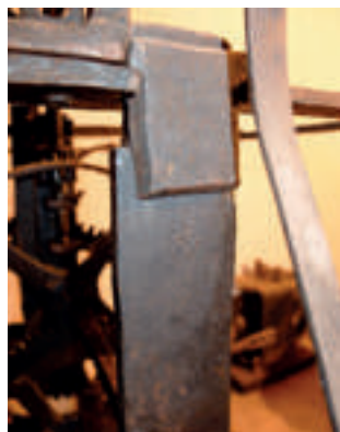
Marcas de ensamblaje y posición del reloj de San Chuan. Pilar 4, soporte del eje del escape y pletina
