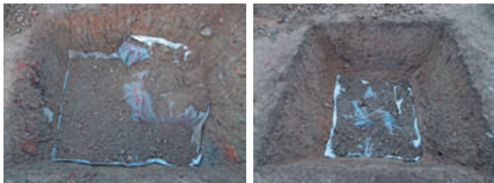
Geotextil en el fondo de los sondeos 1 y 3 respectivamente
