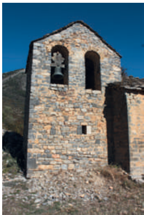
Campanario de la iglesia de Sercué (Fanlo)
