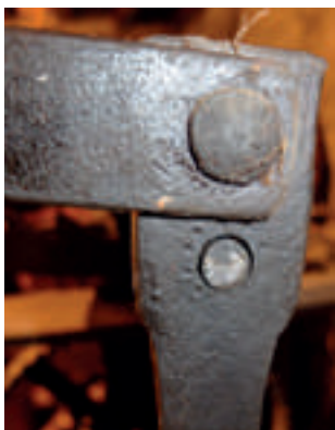
Marcas de ensamblaje y posición del reloj de San Chuan. Pilar 4, soporte del eje del escape y pletina
