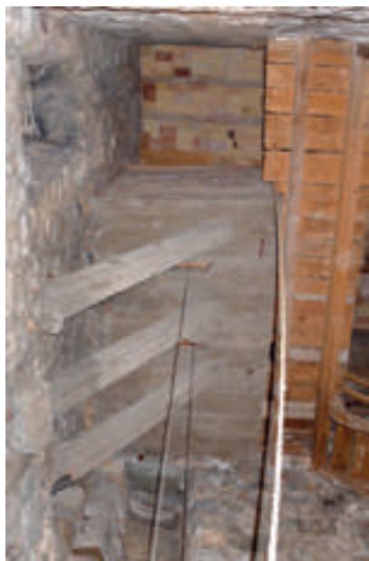
Habitación del reloj en la Asunción de Bielsa, inferior a la sala de campanas
