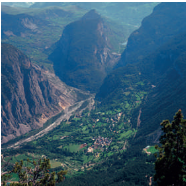
Saravillo y Plandescún. En el acceso al valle de Chistau, el desfiladero de Plandescún y los túneles necesarios para acceder a Plan, fueron la llave imprescindible para desbloquear el camino
