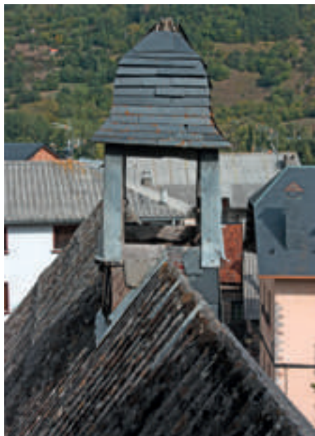
Estructura para una campana de Señales. Iglesia parroquial de Plan
