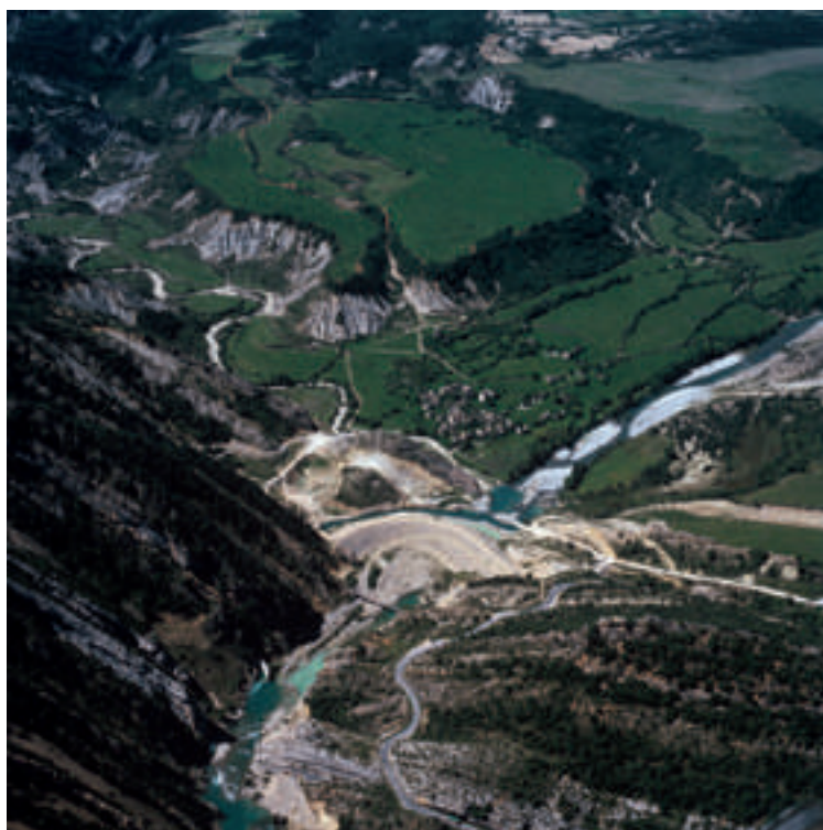
Jánovas. Punto donde la carretera ha superado el desfiladero de Jánovas y toma fuerza para adentrarse en su ribera, camino de Fiscal
