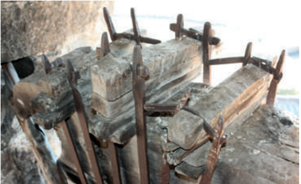
Sistemas de fijación tradicionales de la campana de Puyarruego (Puértolas)
