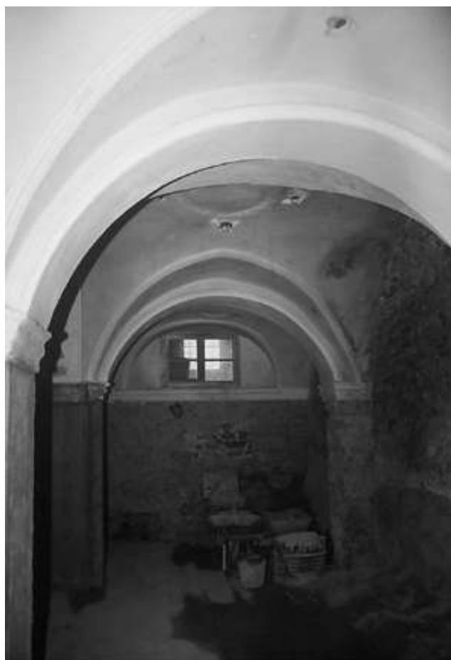
Capilla de acceso al campanario. Bajo la bóveda vaída del s. XVIII que se halla en primer término se oculta una sencilla bóveda de crucería como lo denotan sus nervios (el autor)
