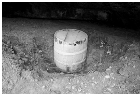
Detalle de la tina de madera para alojar al serpentín, casi colmatada por el lodo arrastrado por el barranco
