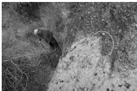
Encima del barranco todavía se puede apreciar el agujero de entrada del agua
