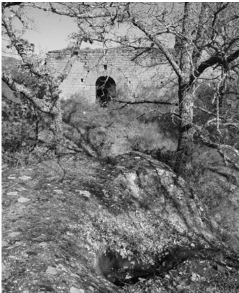
Iglesia ya en ruinas y roca modificada por el ser humano
