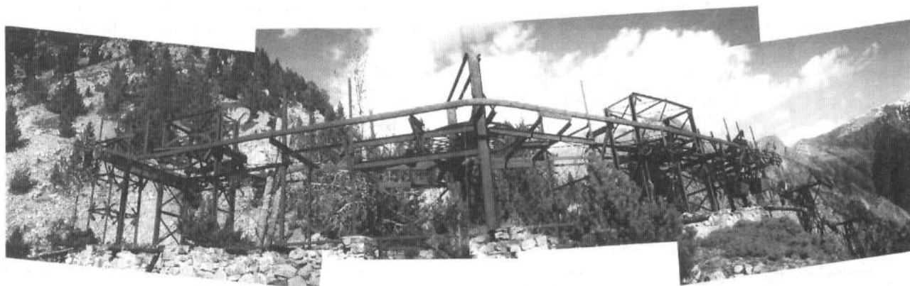
Estación de ángulo del cable aéreo. Foto: Philippe Vivez.
